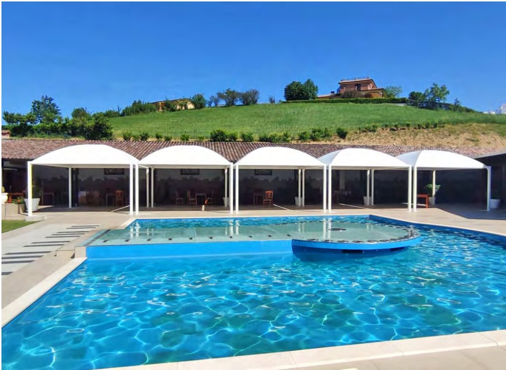
Cicogna System Ristorante La Fornace Colledara (TE)
