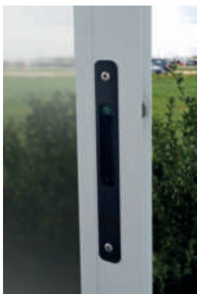
Maniglie integrate nel profilo verticale per l'apertura delle ante handle integrated into the vertical profile for opening of the panels
