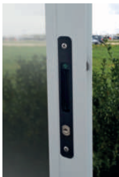
Maniglie integrate nel profilo verticale per l'apertura delle ante handle integrated into the vertical profile for opening of the panels
